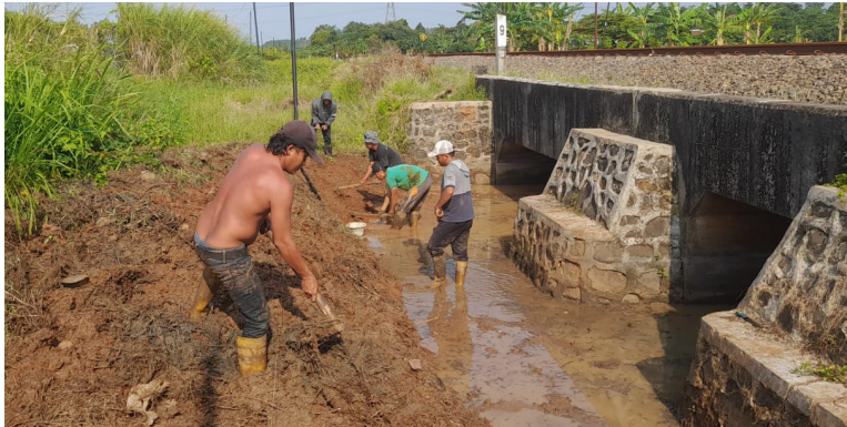
Kegiatan Pembersihan Saluran di Area Dalam PLTU Batang oleh BPI Drainage Channel Cleaning Activities Within the Batang PLTU Area by BPI
